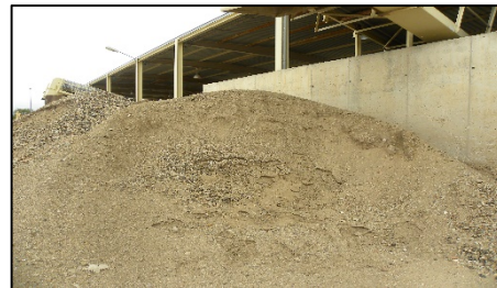
GEDESMA, SA. Tratamiento Integrado de RCD de El Molar (Madrid). Precibado Mezcla Hormigón-Cerámico
